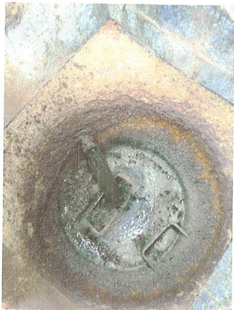
In pozele de mai sus sunt reprezentate degradarile caminului de descarcare a conductei de refulare C185.
